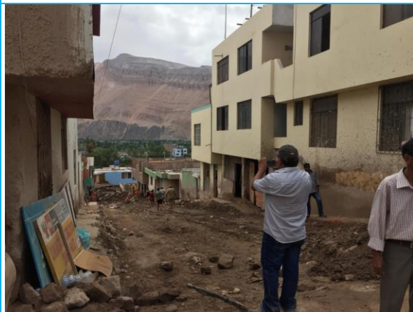
Personal DGPPVU verificando la limpieza de las calles afectadas
