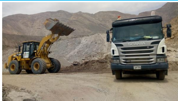
Eliminación de Escombros – PNC Maquinarias del MVCS
